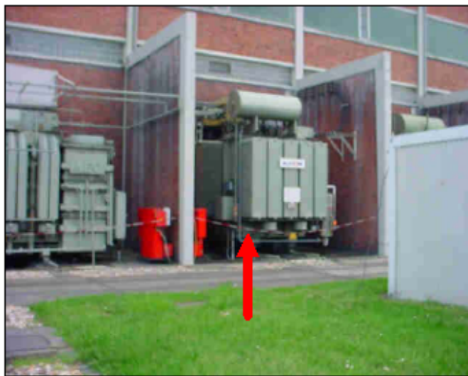
Obr. 4 Oddělení horkého (chráněného) oleje z nádoby od potenciálně kontaminovaného oleje z konzervátoru
