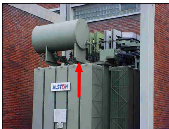
Obr. 1 Teplotní rozložení referenčního transformátoru KM106 (stejný typ, stejná zátěž)
